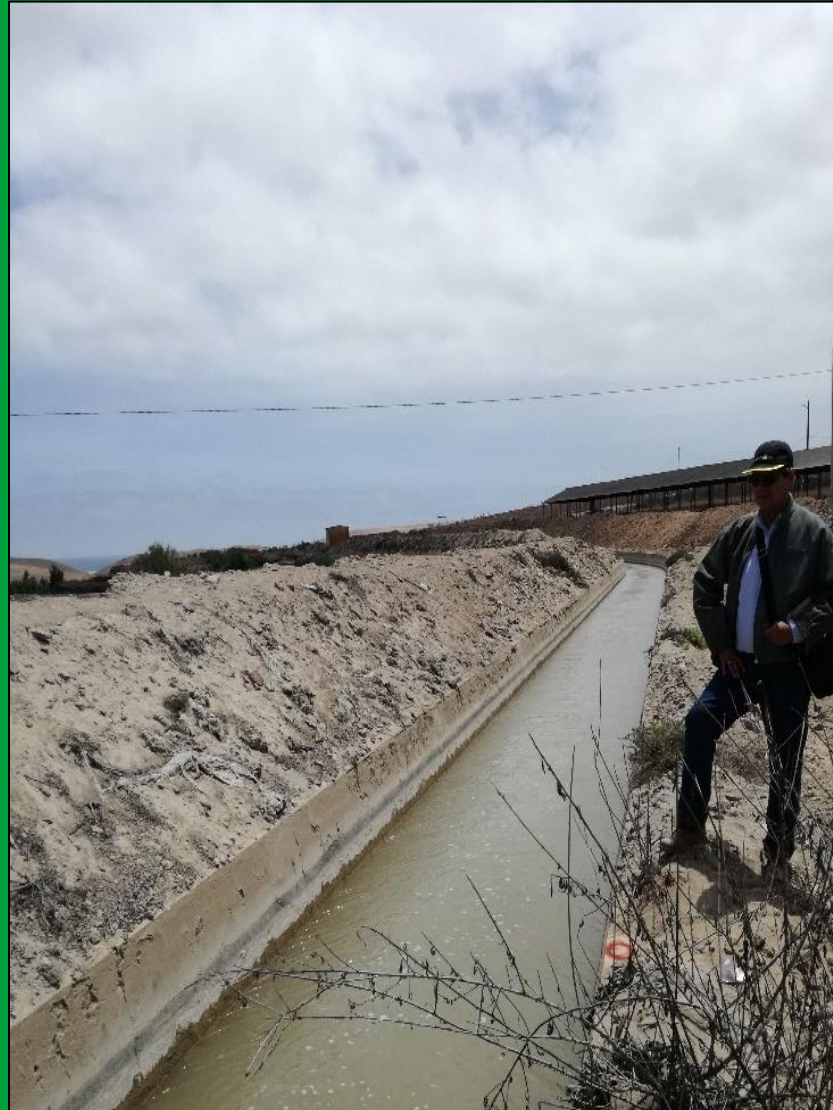
Ubicación del medidor RBC en el canal Mejía
