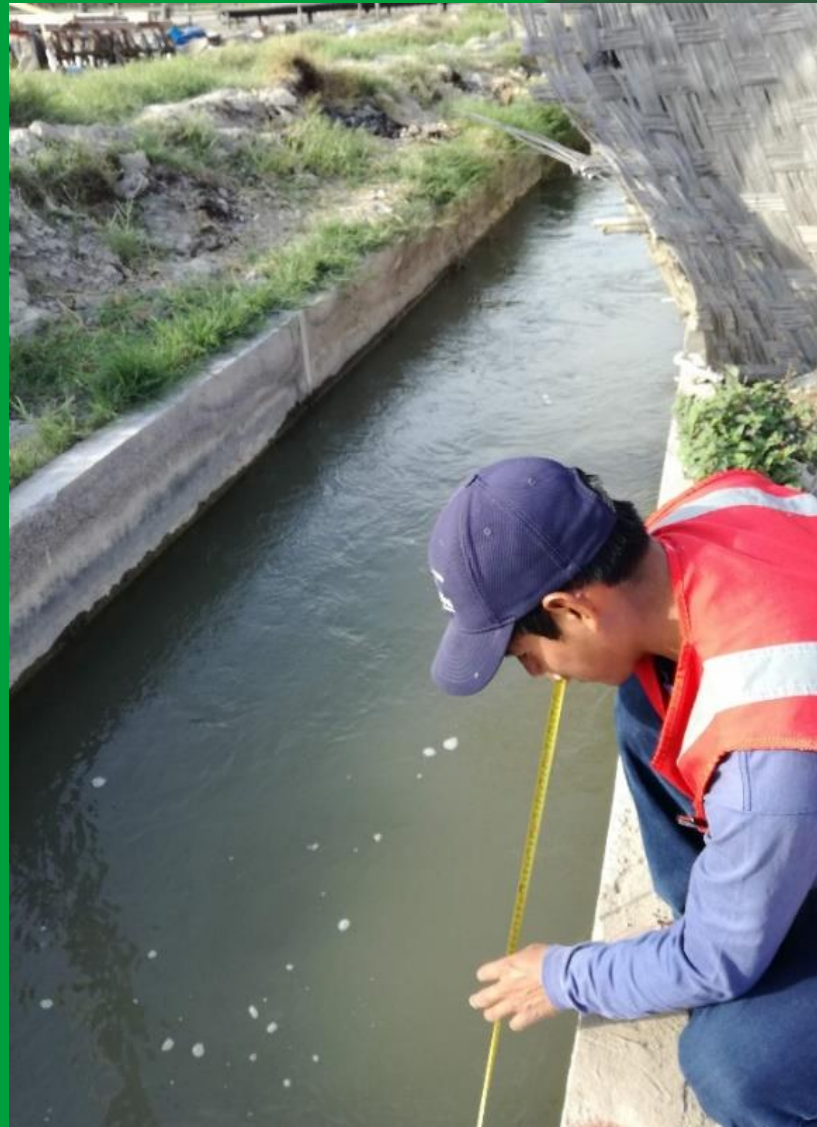
Ubicación del medidor RBC en el canal Crucero
