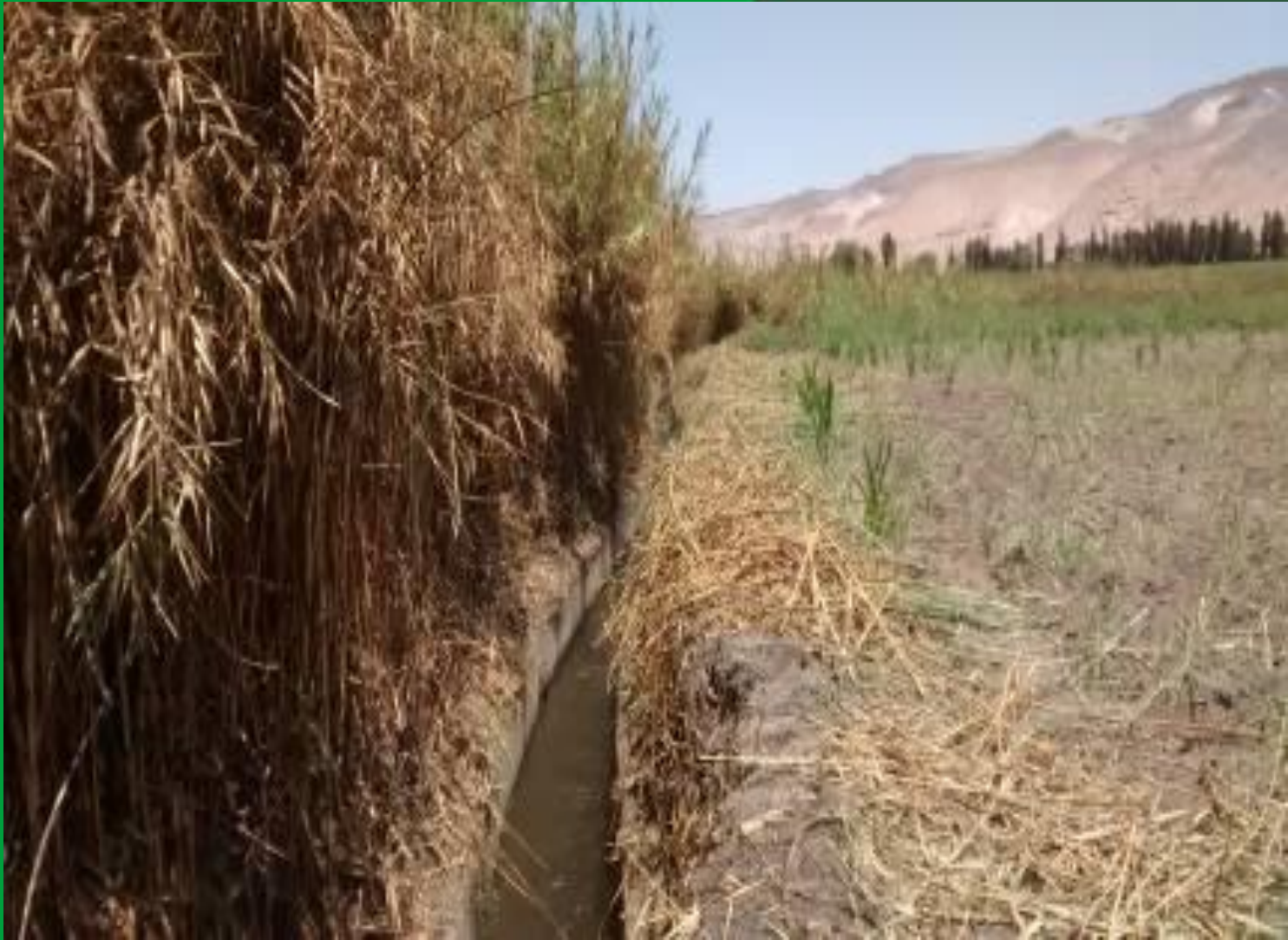
Ubicación del medidor RBC en el CD Valcarcel
