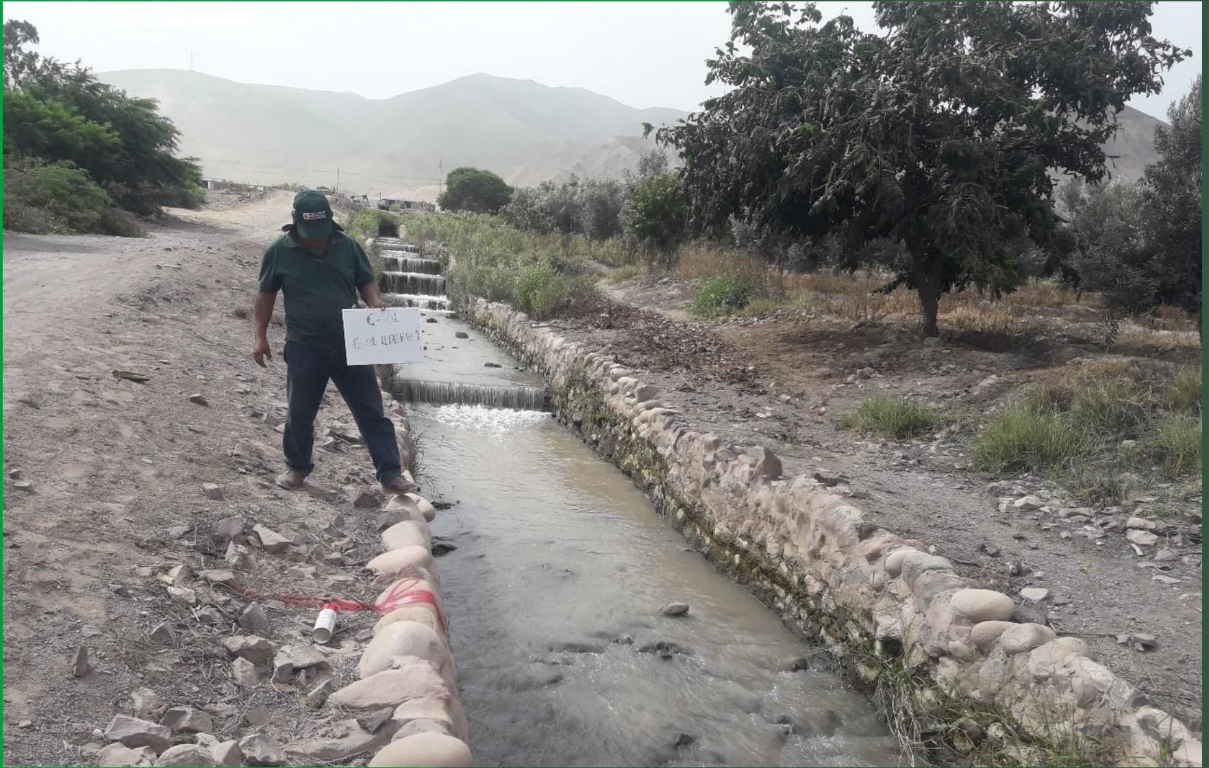
Vista de tramo del Canal L1 Lateral 1 del tramo de ubicación del EMA proyectado-Bella Unión
