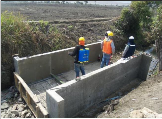
Curado del concreto con producto químico, zona del medidor RBC, Prog. 0+097.20 – 0+101.75, Canal San Bartolo - JUSHM Santa
