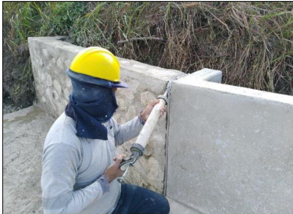
ejecución de Junta de Dilatación sellado con material elastomérico de poliuretano, en la zona del RBC y Transiciones de piedra, Canal San Bartolo - JUSHM Santa
