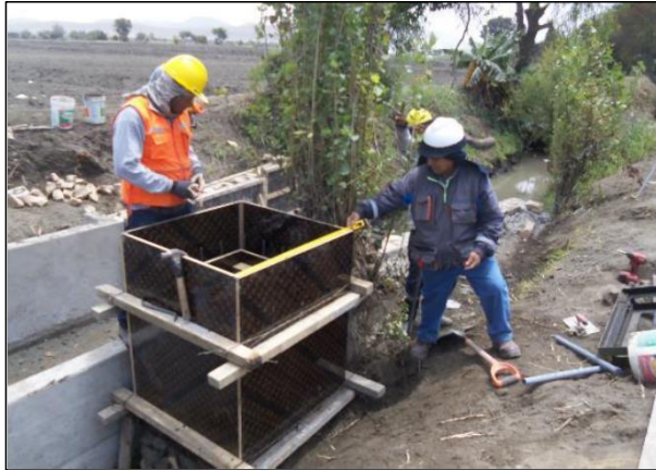
Encofrado de caras externas con paneles fenólicos, para acabado caravista, en la zona de la caja de alojamiento de equipos Canal San Bartolo-JUSHM Santa
