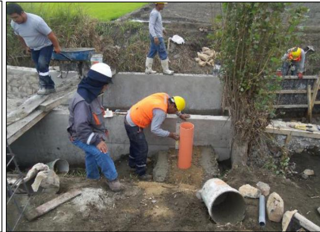
Solado y relleno del área de la tubería de 8" en la zona de la caja de alojamiento de equipos, Canal San Bartolo - JUSHM Santa
