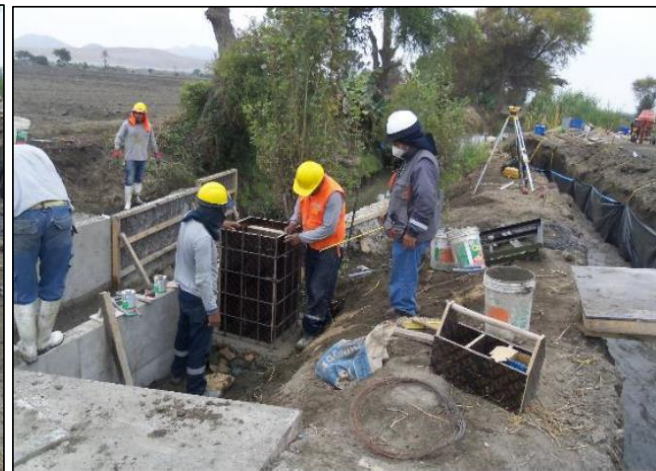
Encofrado de las caras internas con paneles fenólicos, para obtener un acabado caravista, en la zona de la caja de alojamiento de equipos, Canal San Bartolo - JUSHM Santa
