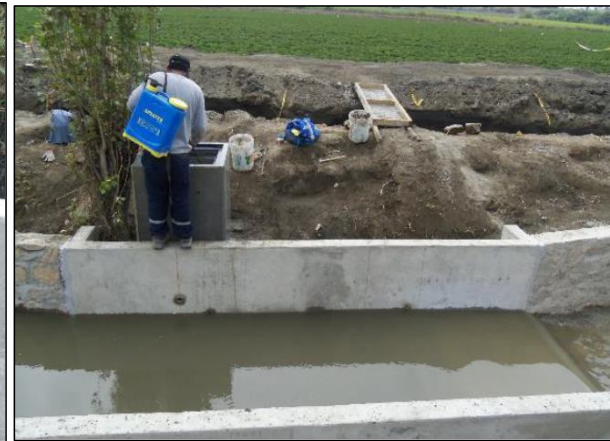
Curado del concreto con producto químico, aplicado con mochila pulverizadora, en la caja de alojamiento de equipos, Canal San Bartolo - JUSHM Santa
