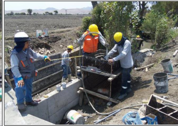
Se aprecia el vibrado, en la zona de la caja de alojamiento de equipos, Canal San Bartolo - JUSHM Santa
