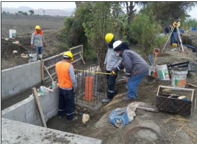
Acero de refuerzo F_y=4200 kg/cm 2 , en la zona de la caja de alojamiento de equipos, Canal San Bartolo - JUSHM Santa
