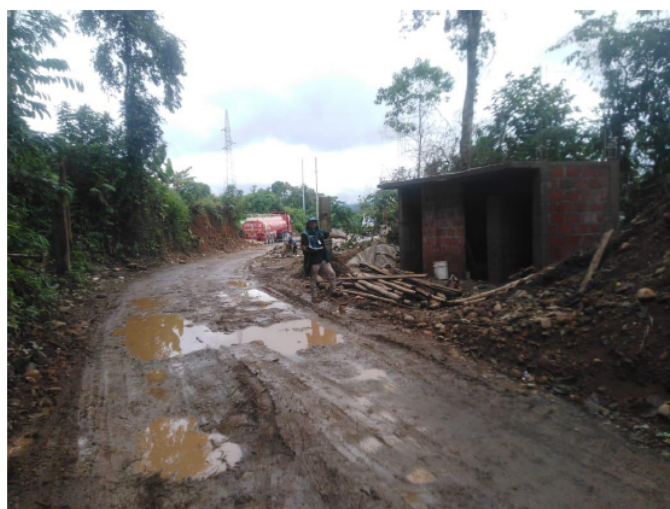
FOTO N° 02: Se aprecia al personal técnico de la ALA Tambopata-Inambari, identificando una infraestructura en la margen derecha del río Inambari.
