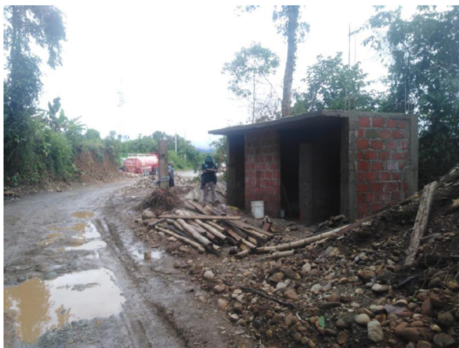
FOTO N° 01: Se aprecia la construcción de 01 baño se servicio, localizado en la coordenada UTM WGS-84 Zona 19 Sur 349303 m E, 8552911 m N en la margen derecha del río Inambari.
