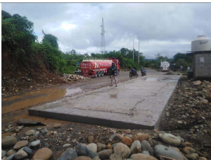
FOTO N° 03: Se aprecia una plataforma de concreto de dimensión 14mx4m y espesor e=0.20 m.
