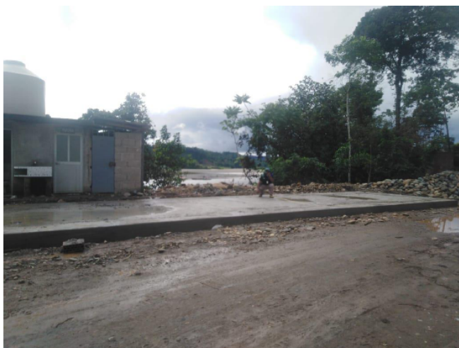
FOTO N° 04: Se aprecia la construcción de 01 plataforma de concreto, localizado en la coordenada UTM WGS-84 Zona 19 Sur 349288 m E, 8552884 m N en la margen derecha del río Inambari.
