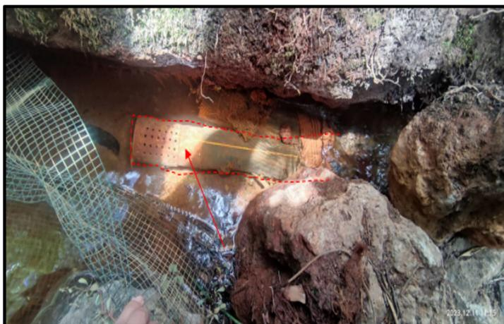
Fotografía N° 01: Captación consistente en una tubería hdpe de 3" con un caudal aproximado de 1.5 l/s, ubicado en las coordenadas UTM WGS 84 497834E, 8622878N, que conduce las aguas al "Recreo turístico Yaku Wasi"
