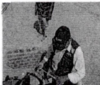
Foto N° 01 En la imagen se aprecia al personal de la Meta N° 39 tomando el Nivel Dinámico del pozo IRHS-11-01-08-1362, el mismo que se encuentra en Estado UTILIZADO.
