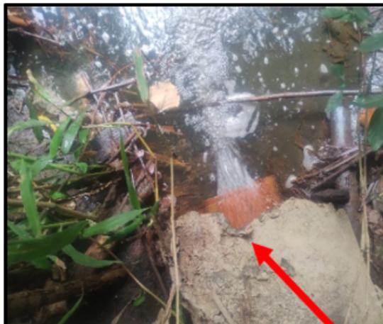
**Fotografía N° 02:** Ubicación de tubería antes de llegar al cuerpo natural de agua Rio Pastaza mostrando vertimiento continuo.
