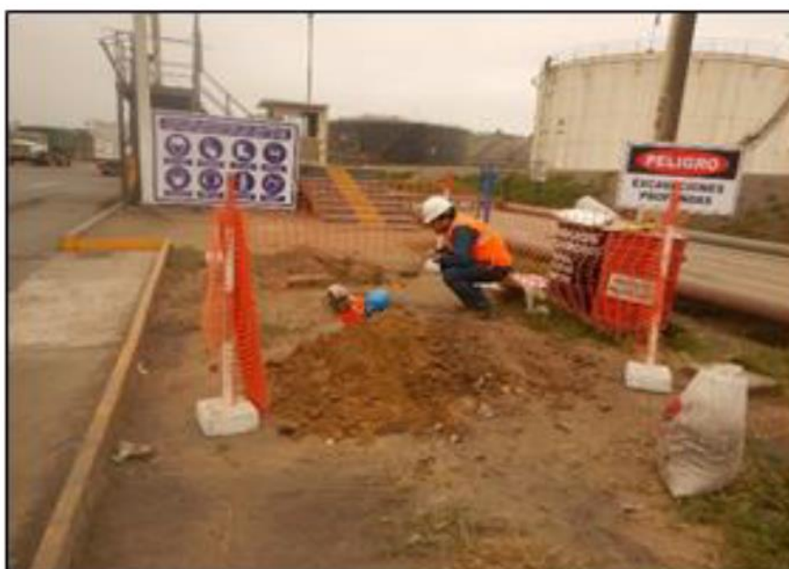
Gráfico N°99: Trabajos de excavación de una calicata manual.
