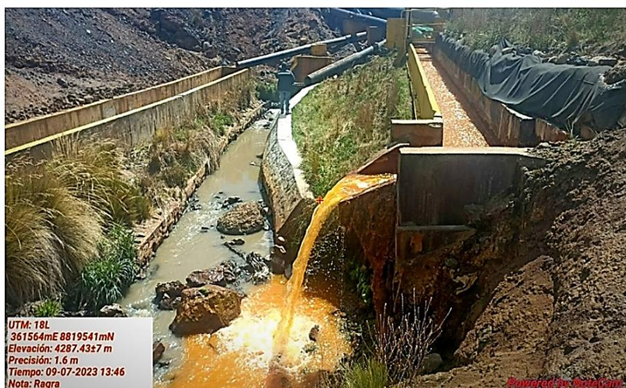
FOTO N° 01: Vertimiento de aguas de coloración naranja hacia la margen izquierda del río Ragra. Punto de vertimiento codificado como "E-204" de Empresa Administradora Cerro S.A.C.
