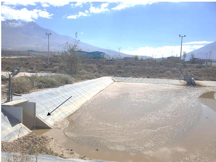
E1, Poza de secado N° 3, con descarga de aguas residuales en dirección a la quebrada, con ataguías abiertas. Fecha 02/09/2022
