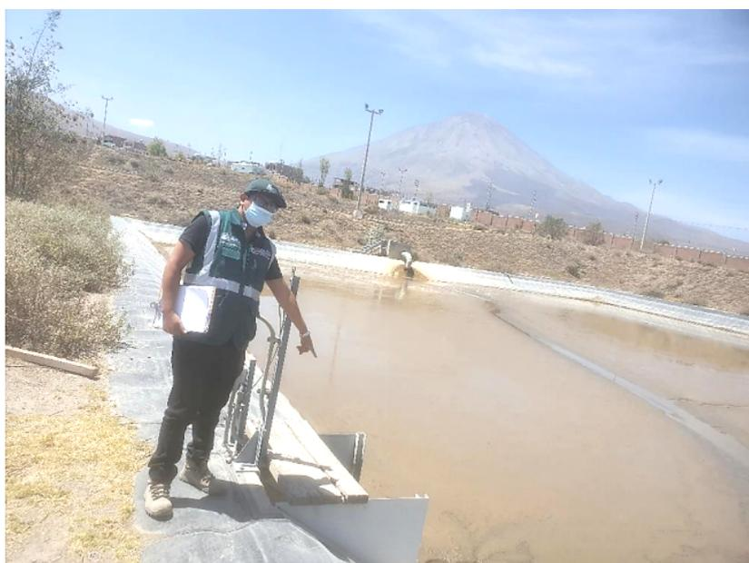
E1, Poza de secado N° 3, con descarga de aguas residuales en dirección a la quebrada, con ataguías abiertas. Fecha 15/09/2022
