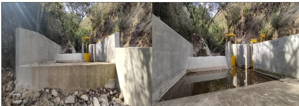
Fig. N°01-02. Obra construida dentro del cauce de la quebrada El Alizar, que contempla los muros laterales, plataforma de concreto y mampostería, barrage, compuerta de metal.
