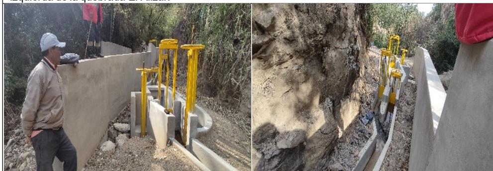
Fig. N°05-06. Canal de concreto armado en la margen izquierda de la quebrada El alizar con compuertas de metal el mismo que aguas más abajo el agua se conduce mediante tubería PVC de 12 pulgadas de diámetro.
