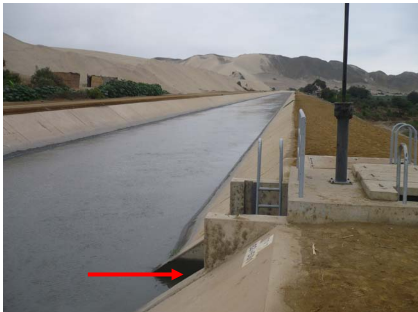
Foto: Toma lateral 4 (Bloque de riego L 4)
